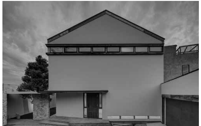
▲海辺に立つ家の外壁を施工
