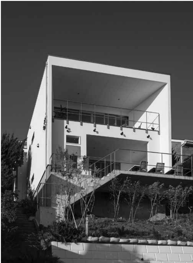
▲傾斜地に立つレストランの外壁を施工
