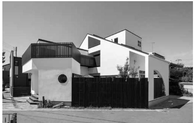
▲外壁全面に漆喰を使用
