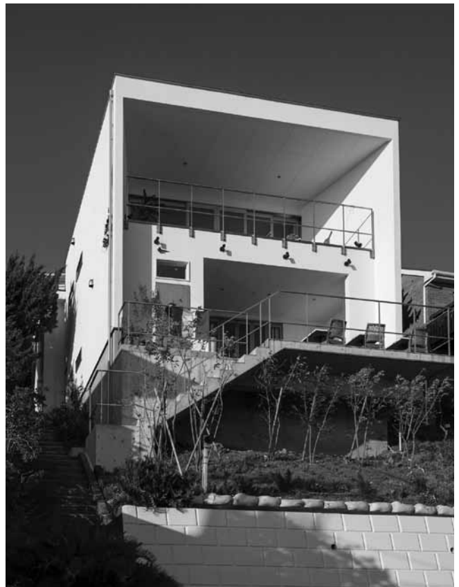
▲傾斜地に立つレストランの外壁を施工
